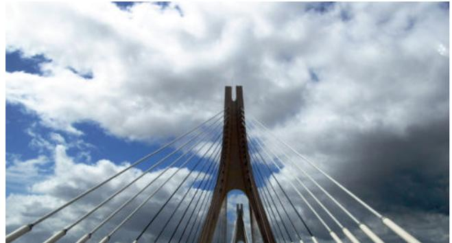
Die Aradebrücke führt, wie der Name schon sagt, über den Fluss Arade nördlich von Portimão. Diese moderne Schrägseilbrücke hat eine Länge von insgesamt 842 Metern. Die Hauptbrücke ist an zwei 61,5 Meter hohen Pylonen aufgehängt und 470 Meter lang.
