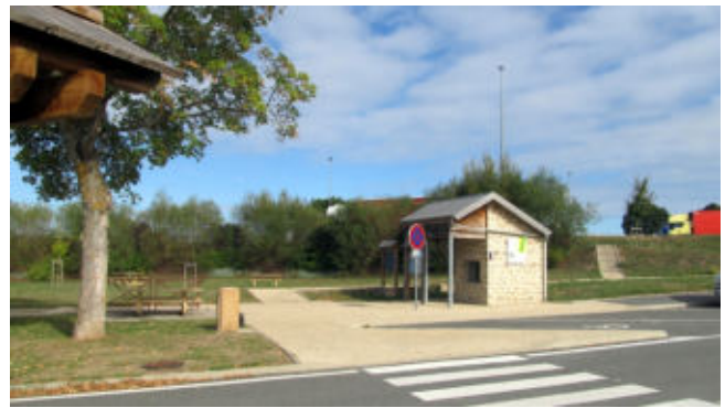
Das Info-Häusl mit Video, hinten oben der LKW-Parkplatz
