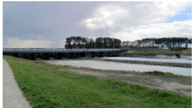
Die Wehranlage flussaufwärts gesehen.
