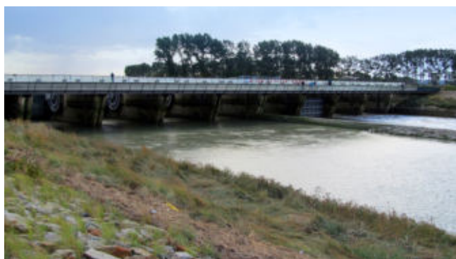
Das Wehr reguliert das Wasser abhängig vom Tidenhub.
