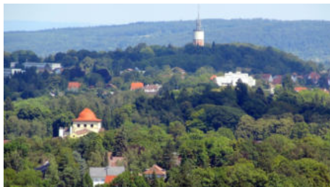
Pforzheimer Wasserturm auf dem Wartberg (Nordstadt)
