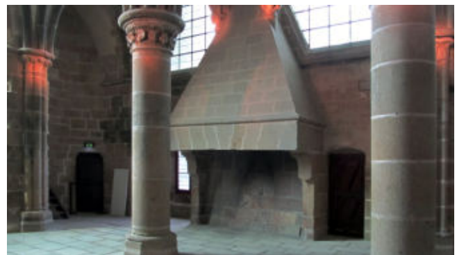
2 Kamine spenden Wärme, ein seltener Luxus. Sogar Latrinen standen zur Verfügung, die sich hinter den beiden Kaminen befanden.
