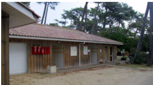
Sanitäranlage ohne Beanstandungen
