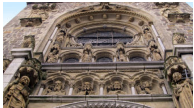
Südwestfassade mit dem großen Rundfenster aus dem Jahr 1986 (Glockenturm)
