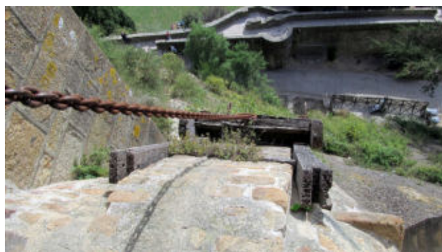
Die Führungshölzer auf der Rampe. Am oberen Bildrand sind die begehbaren Befestigungsmauern zu sehen.
