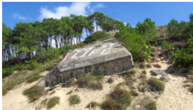
Auch dieser Betonklotz wird irgendwann im Meer landen.
