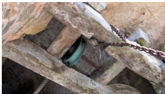
Führungsrolle für das Seil und wahrscheinlich oberer Anschlagsbalken für Kette mit Lastkorb.
