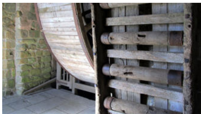
Das riesige "Hamsterrad" (Tretrad) des Lastenaufzugs
