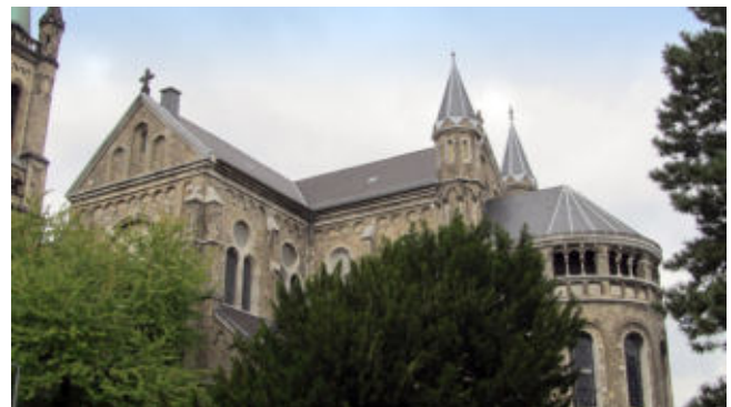
Jakobskirche vom Südwesten (Jakobsplatz) aus
