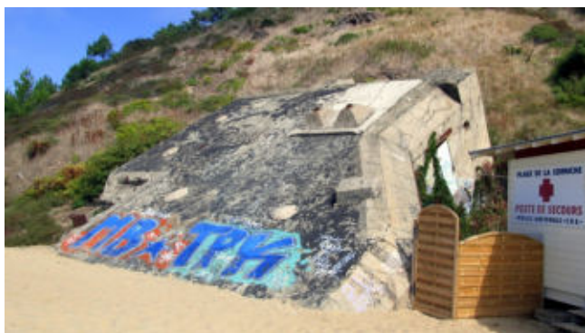
Rechts ist die weiße Bunkertür zu sehen.
