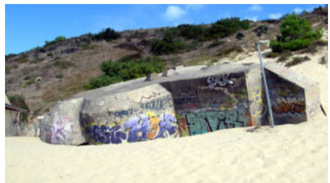
Abgerutschte Westwall-Bunker am nördlichen Dünenende
