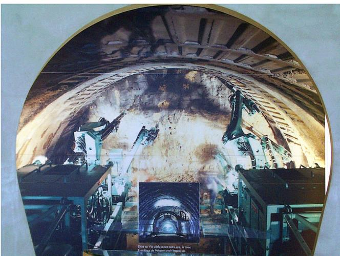
Das Bild zeigt den Tunnelbau, denn die A40 verschwindet auch im Gebirgsmassiv. Für das harte Gestein gab es noch keine geeignete runde Tunnelmaschine, der Fels wurde mühsam mit Meißelmaschinen abgetragen.
