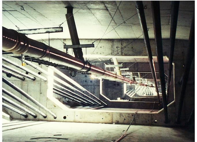
Im Hohlraum unterhalb der Fahrbahn laufen die Versorgungsleitungen und das Abwasserrohr.
